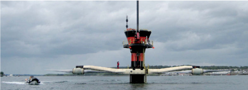
Gezeitenströmungskraftwerk „SeaGen“, Leistung 1,2 MW Quelle: Fraunhofer IEE
