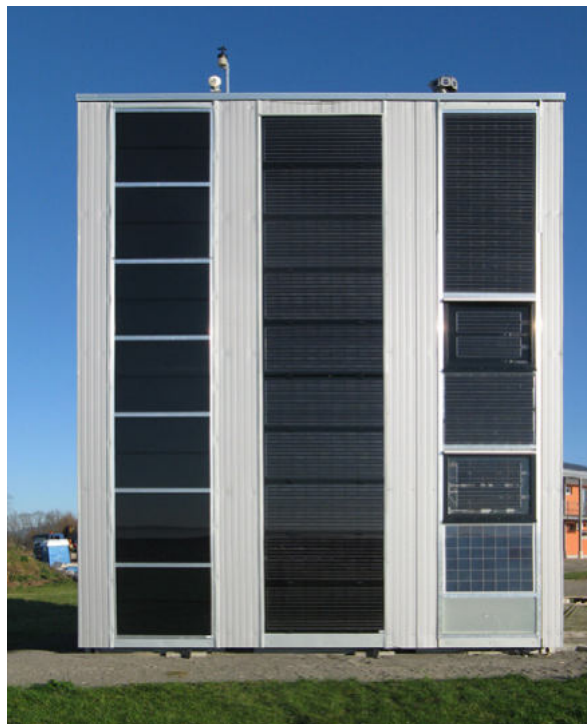
Abbildung 2 PV-Testfassaden am Fraunhofer IWES
