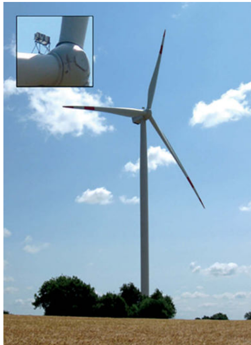
Abbildung 4 LiDAR-Scanner auf der Gondel einer 5MW WEA (links)
