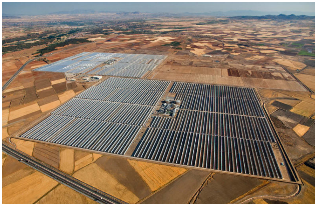
Abbildung 1 Solarthermisches Parabolrinnenkraftwerk in Spanien [DLR]
