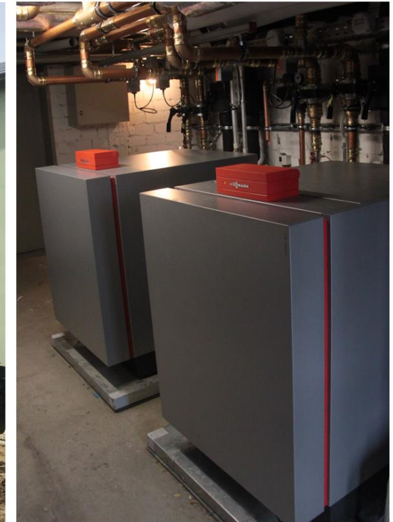
Wärmepumpen
