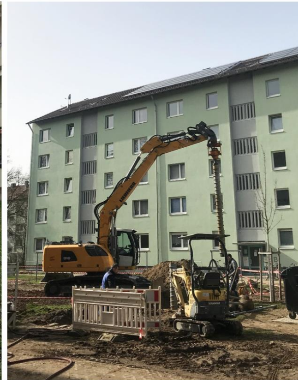
Erdwärmesonden
