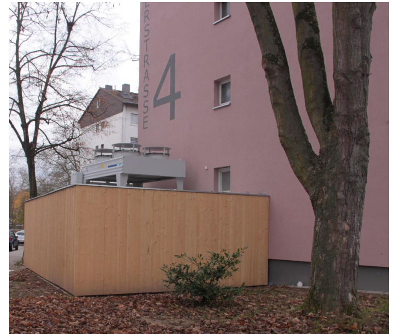
Luft/Sole-Wärmeübertrager auf neu errichtetem Müllhaus
